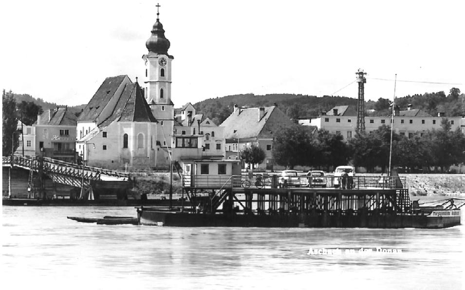
**Das Überfuhrschiff** (die „Überfuhr“) hing an einer ungefähr 300 m (159 Klafter á 1,89m) langen Stangenkette, welche an einer Klobzille befestigt war, die ihrerseits im Strom verankert war. Um ein Durchhängen der schweren Kette zu verhindern, wurde sie noch von mehreren zwischen gestellten Zillen getragen. Die Kraft der Strömung, der Druck, der auf das Steuerruder wirkte, erlaubte das Überfahren alleine mit Hilfe des Wassergerinnes. –
